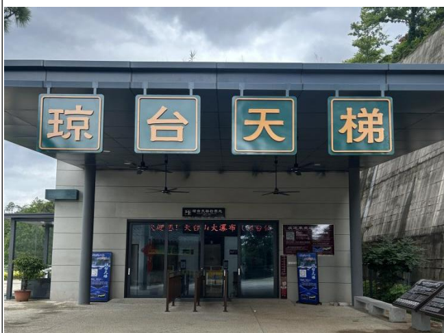
升降电梯（暗梯）
